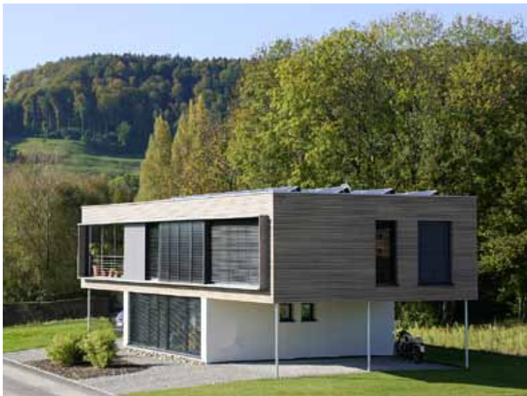
4 Das Passivhaus mit Werkstatt steht in einem Mischgebiet oberhalb der Bodensee-Gemeinde Öhningen an einer Hangkante mit freiem Ausblick auf das gegenüberliegende Schweizer Hügelland.
