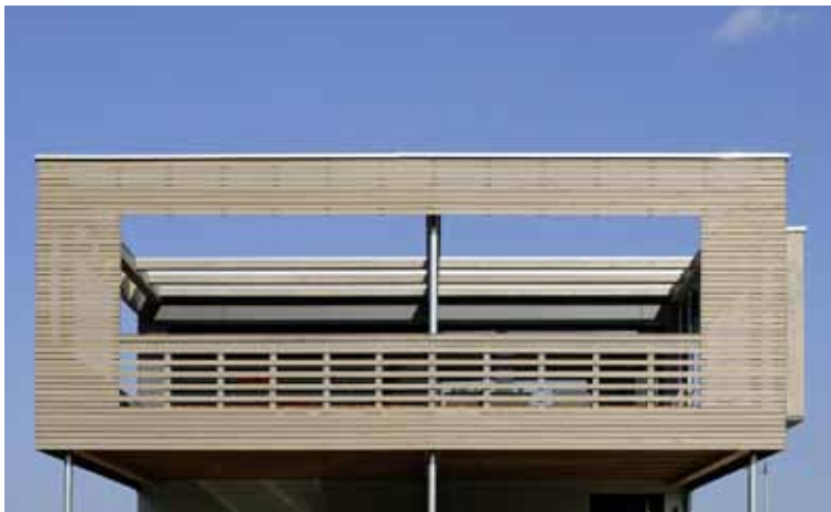
B Das frei stehende und nicht unterkellerte Einfamilienhaus ist ein reiner Holzbau – die Zwischenräume der Holzständerbauweise sind 30 Zentimeter dick mit Zellulose verfüllt.
